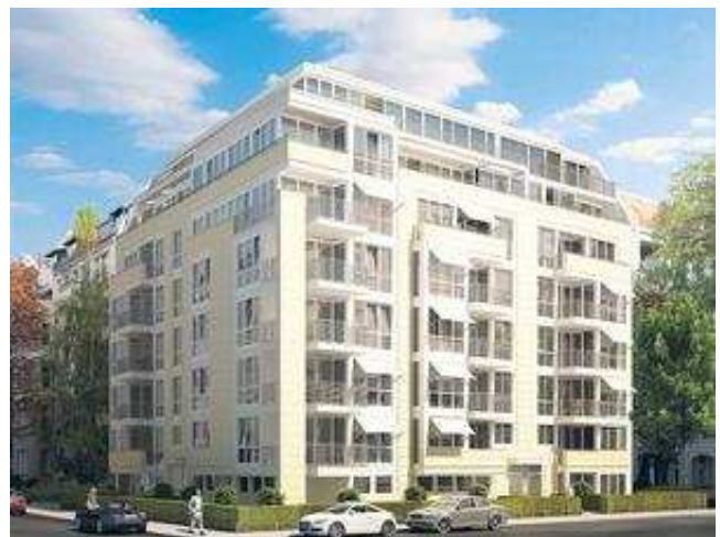
An der Bamberger Straße / Ecke Regensburger Straße, errichtet der Bauträger Egena einen Neubau mit 27 Eigentumswohnungen. Bild: Egena
